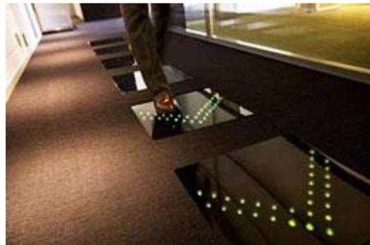
Links: Dieser Teil des Enoshima Aquariums wird von LED-Lampen erleuchtet, die ihren Strom aus dem Power Generation Floor® System beziehen, das die Vibrationen von Schritten in Elektrizität umwandelt.
