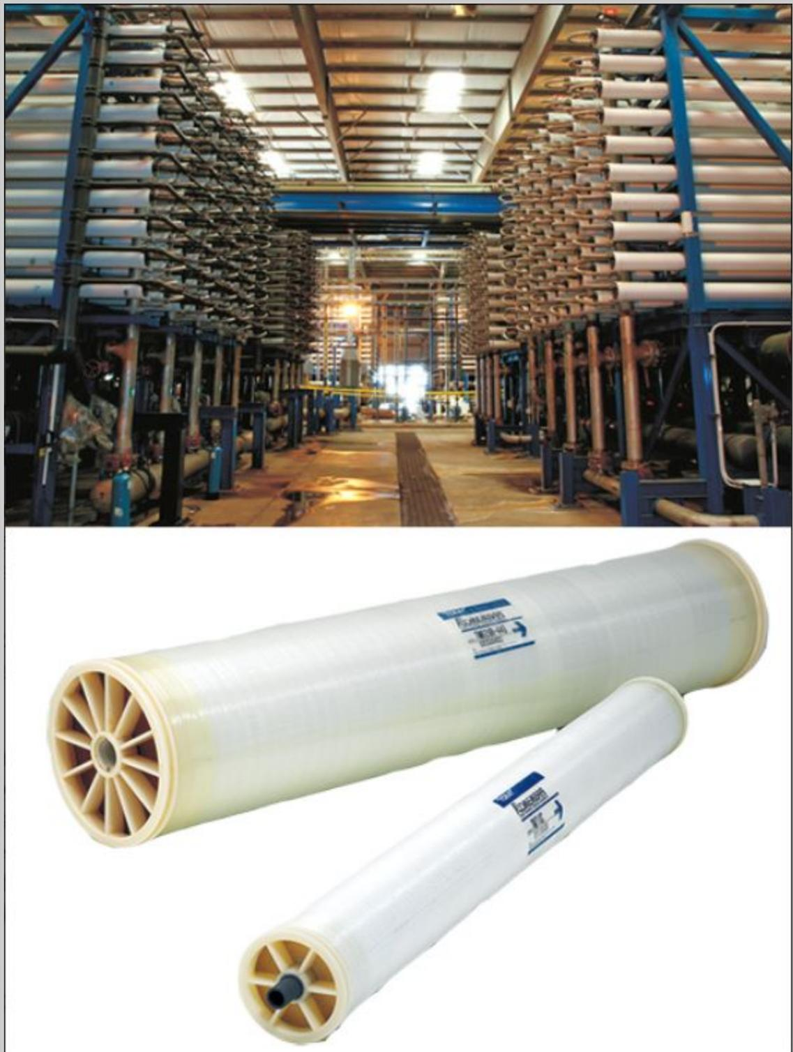
***Bild:** Diese Meerwasserentsalzungsanlage in Trinidad und Tobago nutzt Membranelemente für Umkehrosmose, die von Toray hergestellt werden. (Foto mit freundlicher Unterstützung von Toray Industries, Inc.)*
