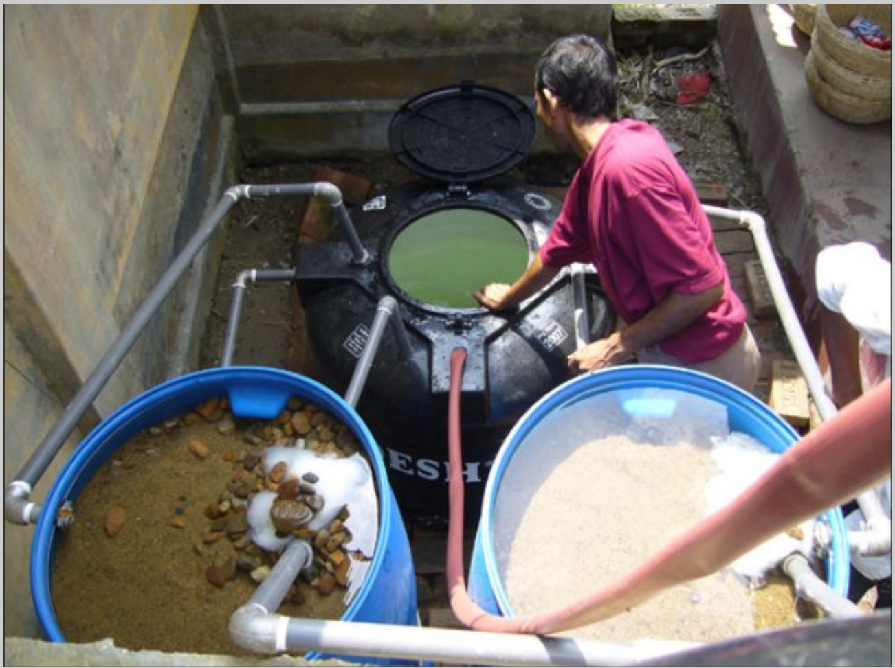
Bild: Die Menschen kommen in den Genuss von sauberem Wasser, indem ein Wirkstoff hinzugegeben wird, der gelöste Partikel verklumpen und auf den Boden der Behälter sinken lässt.
