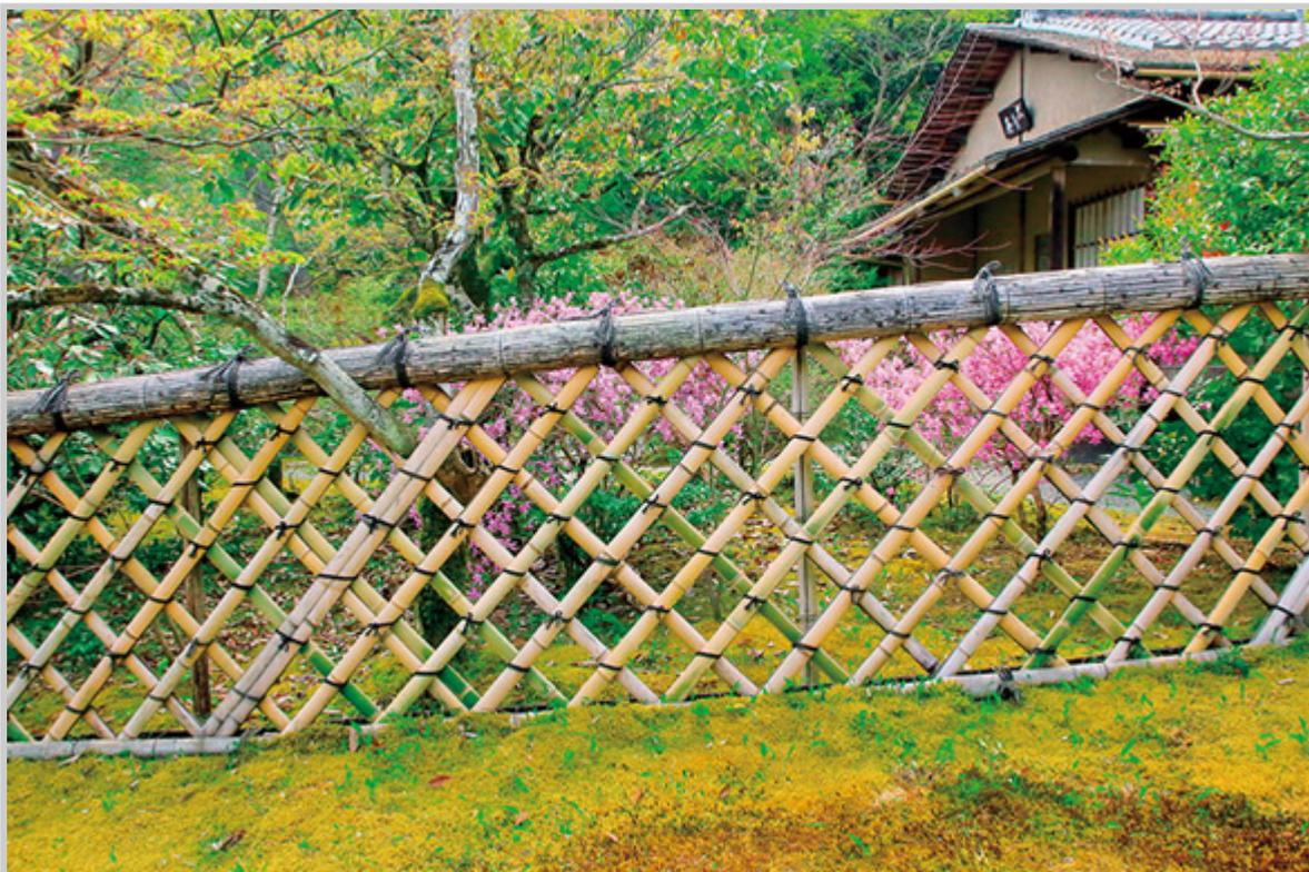
***Bild:** Dieser Bambuszaun steht im Koetsu-Tempel in Kyoto, der bekannt für seinen Japanischen Garten ist. Hier sind gesplittene Bambushalme zu einem groben Diamantmuster zusammengebunden und erlauben dadurch einen Blick auf den Raum jenseits des Zauns.*
